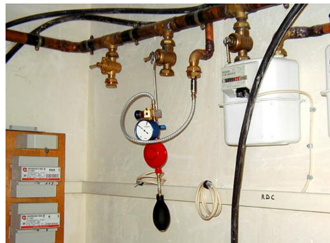
Une étanchéité apparente se teste à la pression de service pendant au moins 10 minutes.
