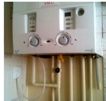
Exemple d'appareil spécifique VMC Gaz raccordé électriquement à une prise à bornes.
